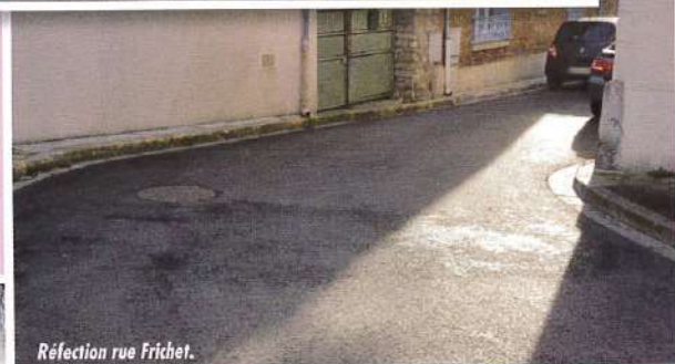
Réfection rue Frichet.
